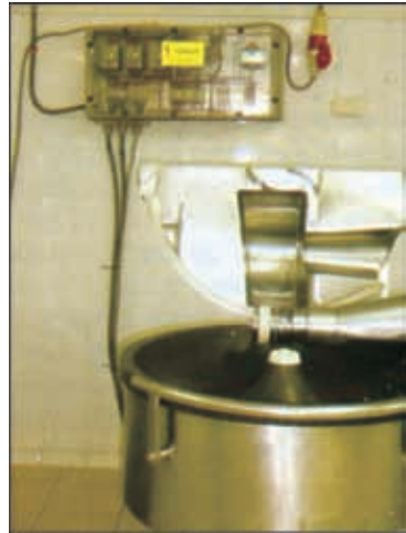
图 478 供电系统中的电线布置位置不正确（太低），清洗此处会比较困难
