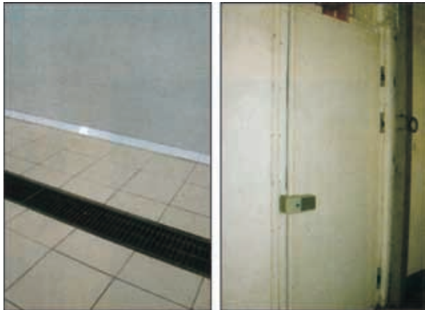
图 473 卫生容易整理的房屋 左边是设有排水沟的地板和拥有拱形接口的墙壁，右边是冷冻室的塑料门
