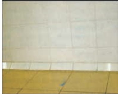
图475 “容易清洗”，光滑的地板与墙砖，地板与墙壁结合处的拱形物
