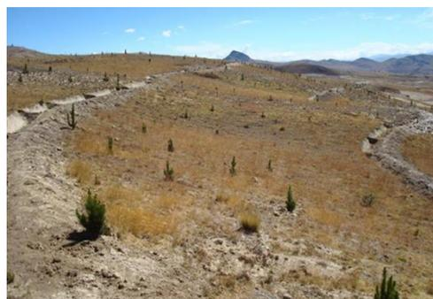
Las zanjas de Infiltración que se practica en la comunidad de Cuyuni son; Zanjas de Infiltración en Pastos, aperturadas a nivel comunal en la parte alta de la cuenca donde se
