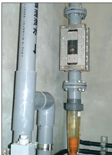
Figure 6.5: Électrolyseur avec débitmètre utilisé pour la purification des huîtres
