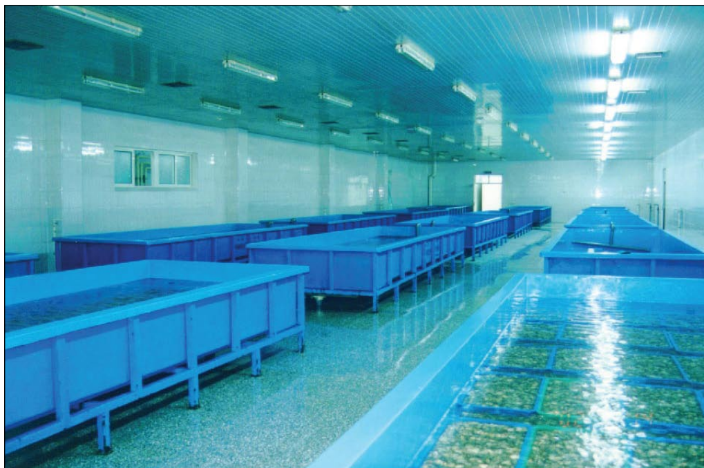
Figure 5.3: Intérieur d'une grande station de purification en Chine
