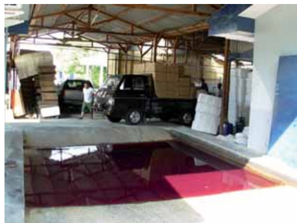
La désinfection par rotoluve (bain désinfectant pour les roues des véhicules) et pédiluve (bains désinfectants pour les chaussures des personnes pénétrant dans les installations aquacoles) réduit le risque de contamination.
