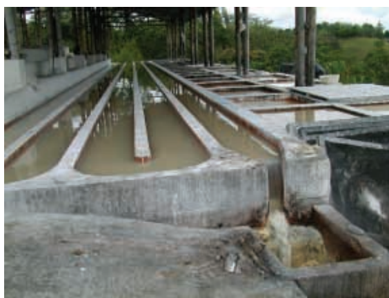
Lámina 23 Tanques y canales de sedimentación
