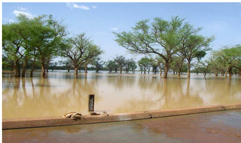
Burkina Faso : Petit barrage à vocation agricole et pastorale
