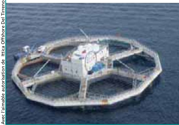
FIGURE 15 Une plateforme piscicole flottante équipée de six larges cages et d'un bâtiment de travail de deux étages (Naples, Italie)
