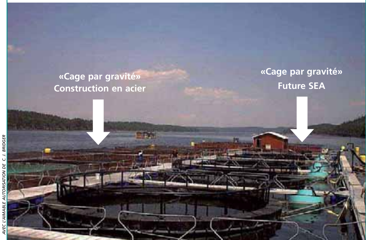
FIGURE 9 Comparaison entre des cages standard basées en surface et munies de bagues et le système Future SEA
