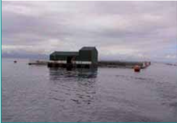
FIGURE 9 Barge/maison flottante sur des cages avec hébergement de l'équipe et zone de stockage d'aliments
