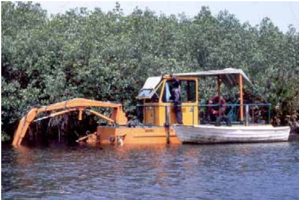
Figure 2. Dragage dans les mangroves de la Basse Volta pour maintenir l'accès à l'eau par les communautés
