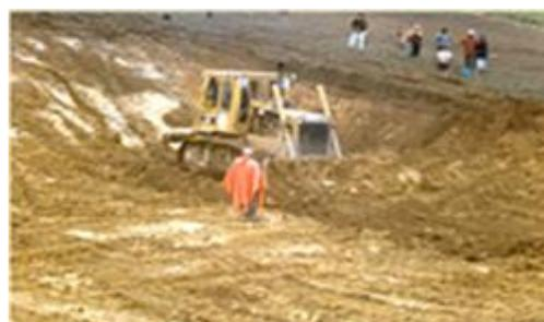
El tiempo para lograr la impermeabilización depende de la naturaleza del material parental o sustrato, así como de la calidad y cantidad de los sedimentos que las aguas de recarga acarrearán en suspensión. Se contempla la utilización de arcilla como material de préstamo para agilizar o completar la impermeabilización de los reservorios.
