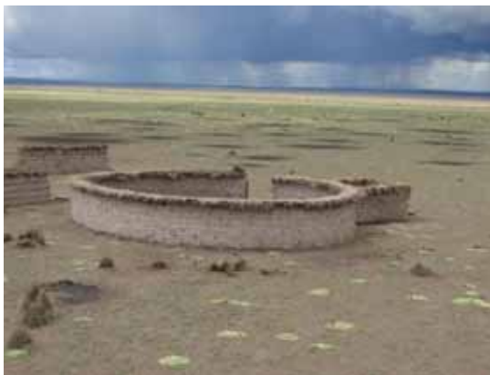
Corral construido con adobes de barro
