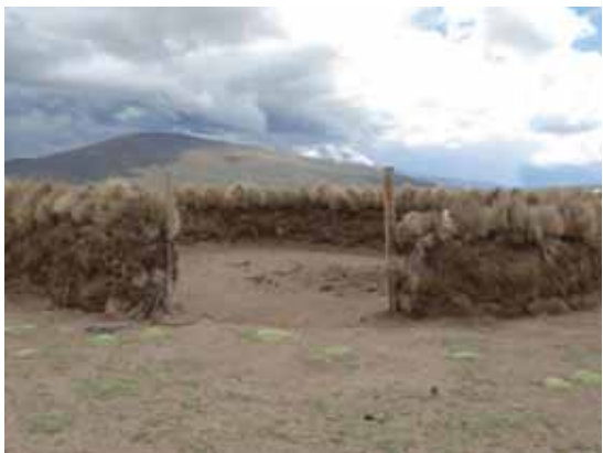
Corral construido con tepes de pajonal
