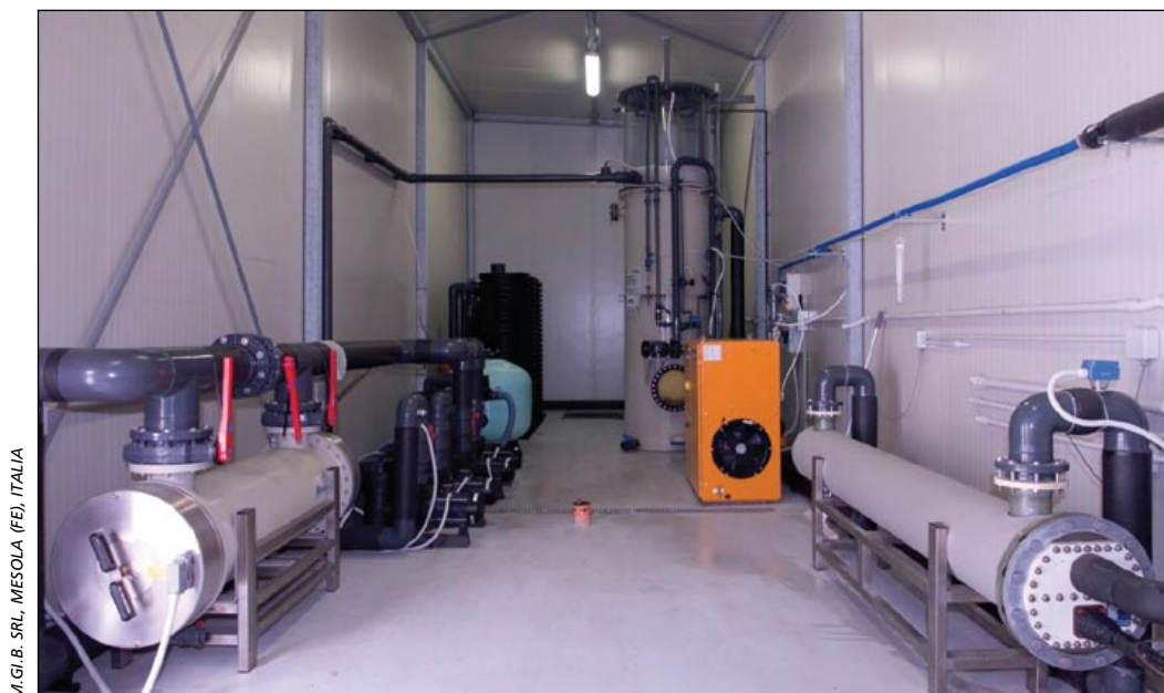
Figure 6.4: Deux imposantes unités de traitement UV installées dans une grande station de purification
