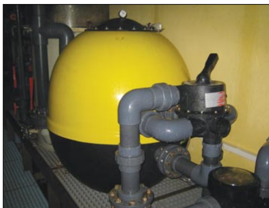
Figure 6.2: Filtre à sable sous pression utilisé dans un système de purification
