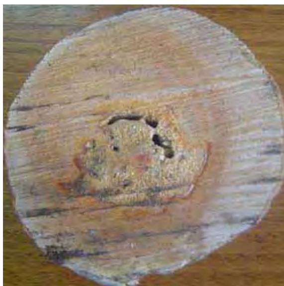
Figura 34. Daño ocasionado por Chilecomadia valdiviana (A. Baldini).
