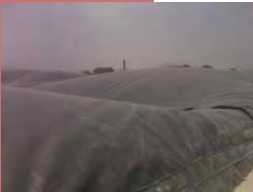
Couverture de méthane sur le premier lagon de traitement des effluents. 9 mai 2009, Perote, Veracruz, Mexique
