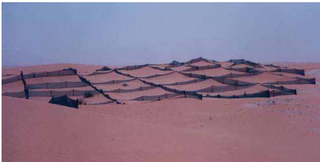
Clayonnage en polystyrène extrudé
