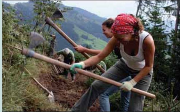
Construction de chemins d'accès à la forêt, Entlebuch, Suisse
