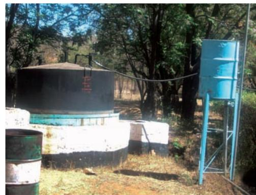
Le réservoir de collecte des gaz s'appuie sur un digesteur construit en béton. Les tuyaux / tubes au sommet du réservoir de gaz approvisionnent la maison avec du gaz méthane, au Botswana. (Reuben Sebegu)
