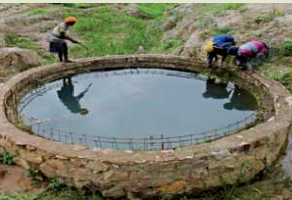
Réservoir utilisé au Rwanda pour irriguer les cultures.
