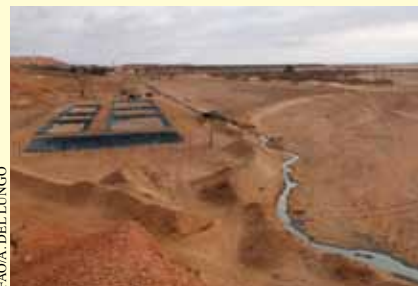
Le système de phytoépuration de l'oasis de Brézina est en train d'être installé avec le soutien de l'Université de la Tuscia
