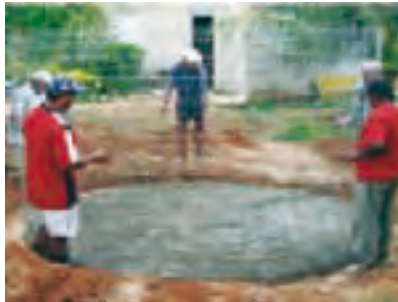
FIGURA 17-V: Detalles constructivos del modelo de cisterna hecho con malla de alambre y mezcla de cemento y arena.
