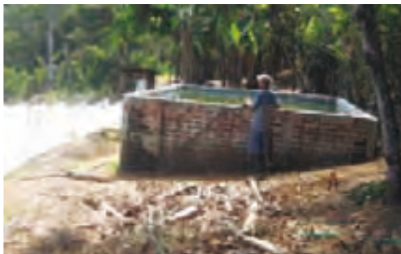
Estanque rectangular construido con ladrillos y hormigón para su utilización en pequeños sistemas de riego. La aplicación de una capa de revoque también del lado externo podría aumentar la impermeabilización. Foto: José Cristóbal Escobar Betancourt.
