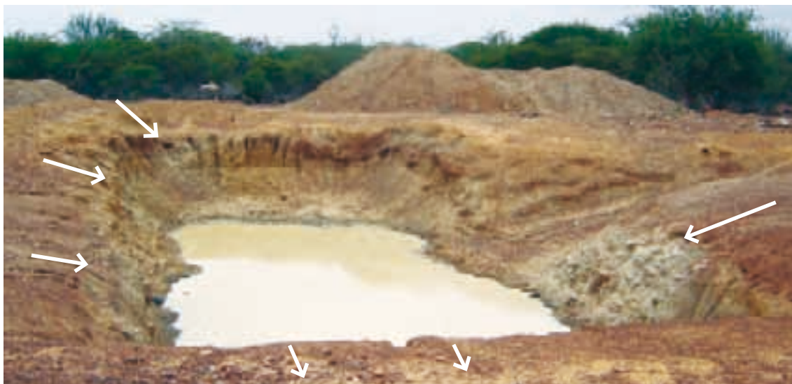
FIGURA 17-X: Ejemplo de una trinchera con erosión en las orillas debido a la pendiente hacia dentro.
