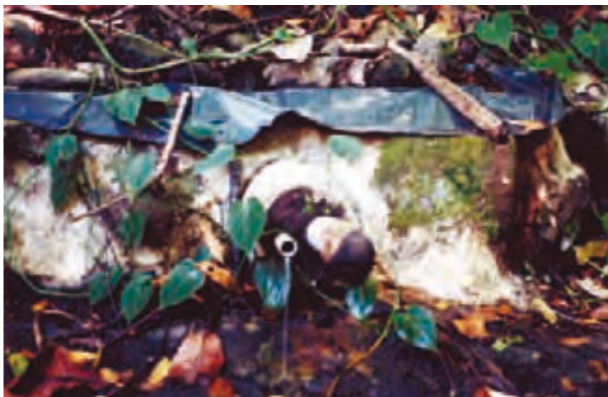
Captación de manantial de caudal crítico (0,5 litros min -1 ), con pequeña presa de mampostería, relleno de piedras para drenaje, cobertura con lámina plástica, protección superior con piedras, tubo para desagüe y conducción. Esta estructura de captación tuvo un costo de USD 20, a precios de 2002. El manantial no estaba en uso por el productor, por ser muy pequeño y casi imperceptible sin la estructura de captación. Foto: Marcos J. Vieira.
