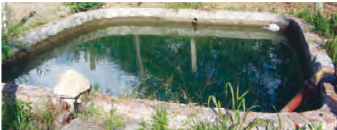
Estanque rectangular construido con ladrillos y mezcla (observe la posición de los ladrillos) para su utilización en abrevadero. Las esquinas redondeadas ofrecen mayor seguridad y facilidad de limpieza. El revoque fue aplicado en la parte interna. Foto: Marcos J. Vieira.
