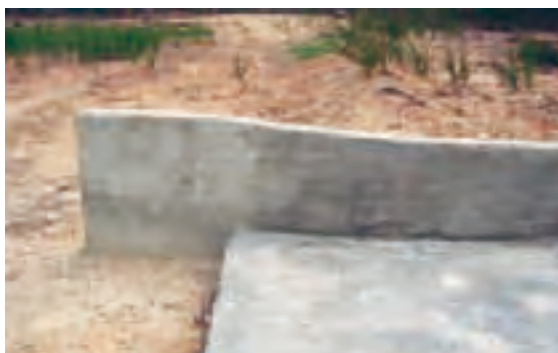
Vista del camellón de contención desde el vertedero. Observar que el camellón posee la cima nivelada hasta perderse en el terreno lateral más elevado. Nótese que el camellón fue conformado con suelo de aguas arriba.
