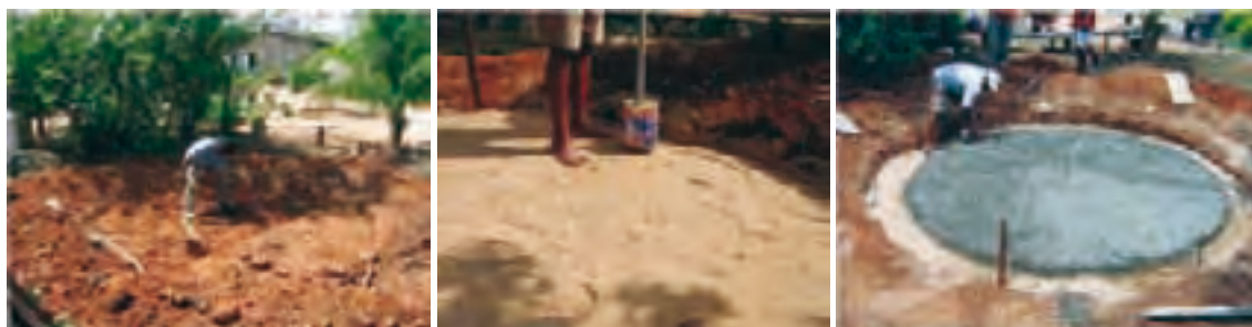
FIGURA 17-II: Fases de la preparación de la base de una cisterna circular, con la excavación, compactación con capa de grava y arena y piso falso de mezcla.
