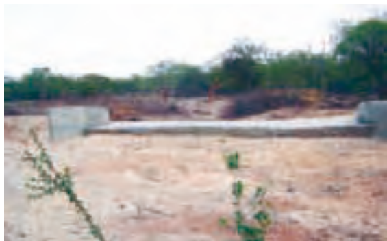
Vista del vertedero desde el área de cultivo. Observar que la base está a unos 0,30 m arriba del nivel del suelo, para retener parte de la escorrentía y recargar la napa freática. Aguas abajo, se puede observar el lugar donde se concentran los flujos de agua superficiales.
