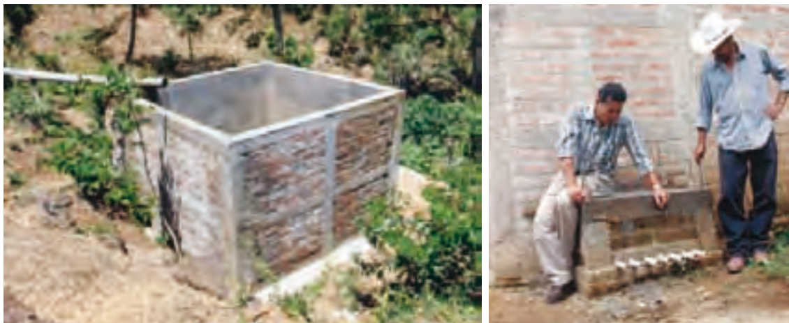
Los sistemas de captación de cursos de agua para riego u otras finalidades son complementados con estanques de transición y derivación, estratégicamente ubicados. En estos estanques de derivación es posible establecer volúmenes de utilización para cada usuario. Fotos: Nelson González.
