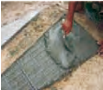
FIGURA 17-V: Detalles constructivos del modelo de cisterna hecho con malla de alambre y mezcla de cemento y arena.
