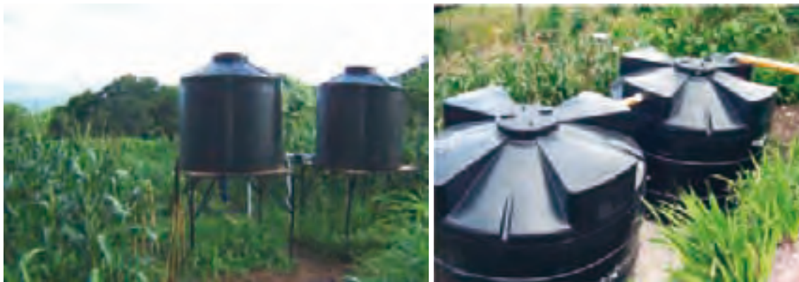
FIGURA 17-XIII: Estanques de material sintético destinados al almacenamiento de agua para uso doméstico y riego por goteo.
