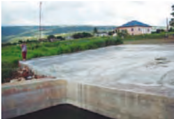
FIGURA 17-XIV: Patio y cisterna de hormigón.
