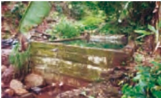
Estanque de hormigón para almacenamiento primario en captación y derivación del yacimiento para pequeño riego. Note que una parte está enclavada en la roca lateral y al lado del torrente de la quebrada. Foto: José Cristóbal Escobar Betancourt.
