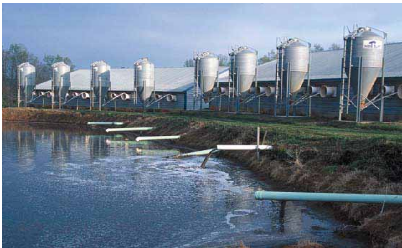
Système ultramoderne de gestion des résidus en bassins pour une exploitation porcine de 900 têtes. Les installations sont complètement automatisées et à température contrôlée.
