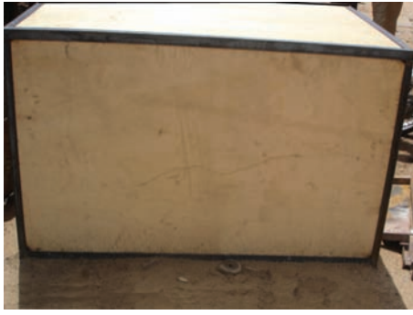
PHOTO 10 Fixation des panneaux par des cornières en fer
