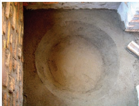
PHOTO 35 Matérialisation du creux de feu dans le foyer
