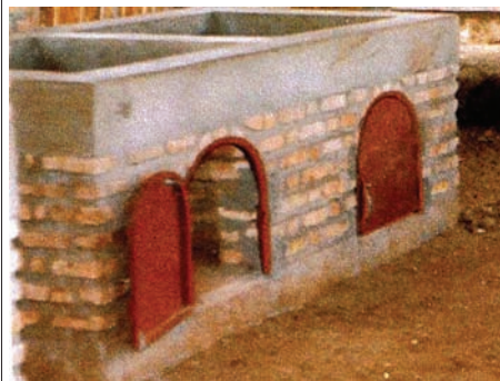
PHOTO 36 Montage des portillons
