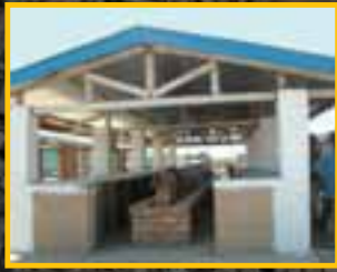
Le pavillon, qui vient d'être construit
