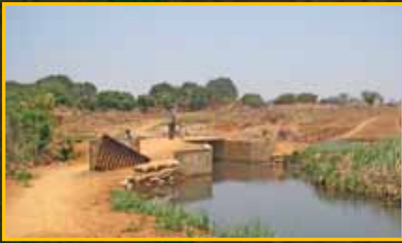
Début d'un canal de 6 km de long, l'une des premières interventions du projet à Kilobelobe
