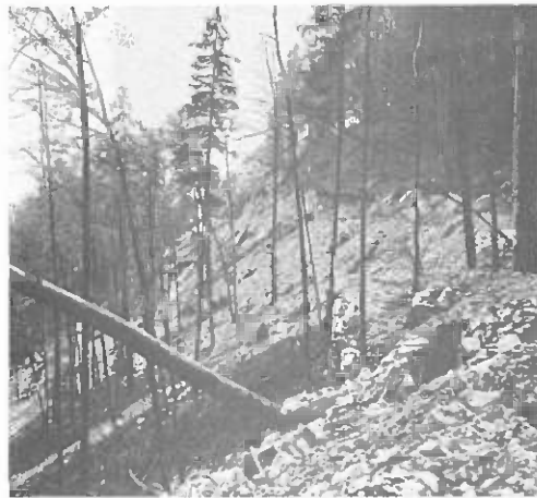
Matériaux provenant de travail à l'explosif déposés sur une forte pente (Photo: M. Jedlitschka)
