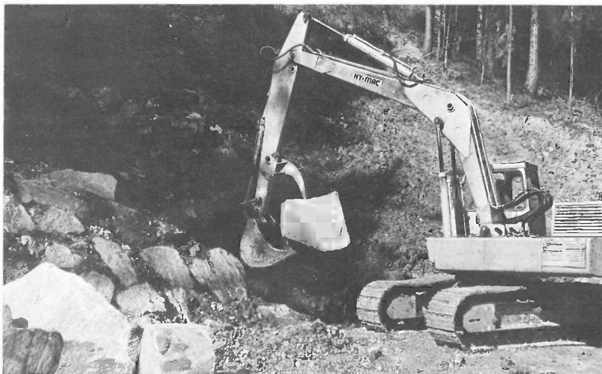
Construction d'un mur de soutènement au moyen de blocs de rochers mis en place sur le talus de déblais par une excavatrice (Photo: O. Sedlak)
