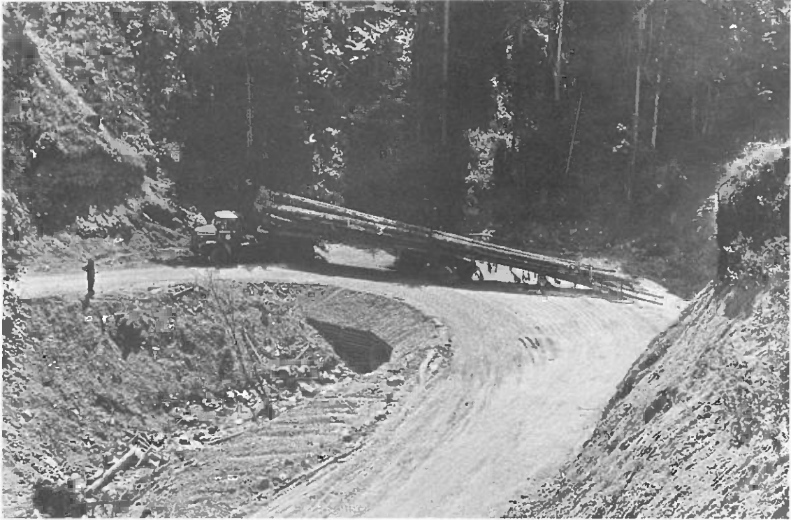
Fûts entiers transportés sur camion avec remorque. Remarquer les caractéristiques de haut niveau de la route (courbe et largeur) (Photo: E. Pestal)
