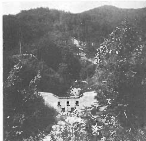
Barrage de retenue en béton (Photo: M. Jedlitschka)
