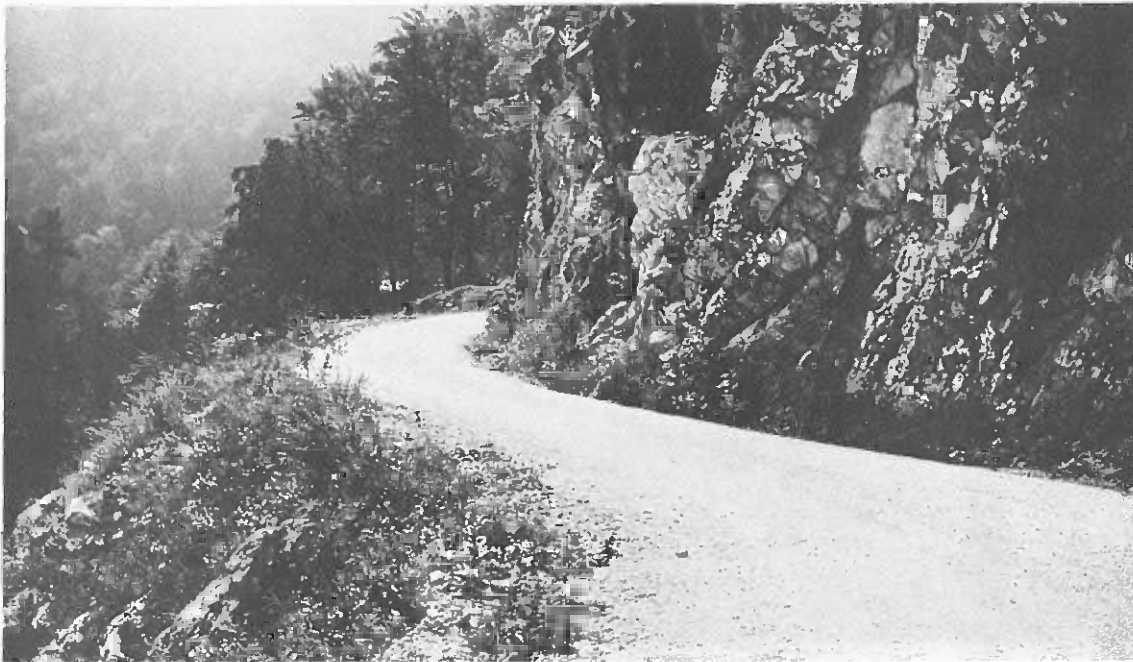
Route forestière bien tracée en terrain accidenté avec les talus des remblais recouverts de végétation (Photo: R. Heinrich)
