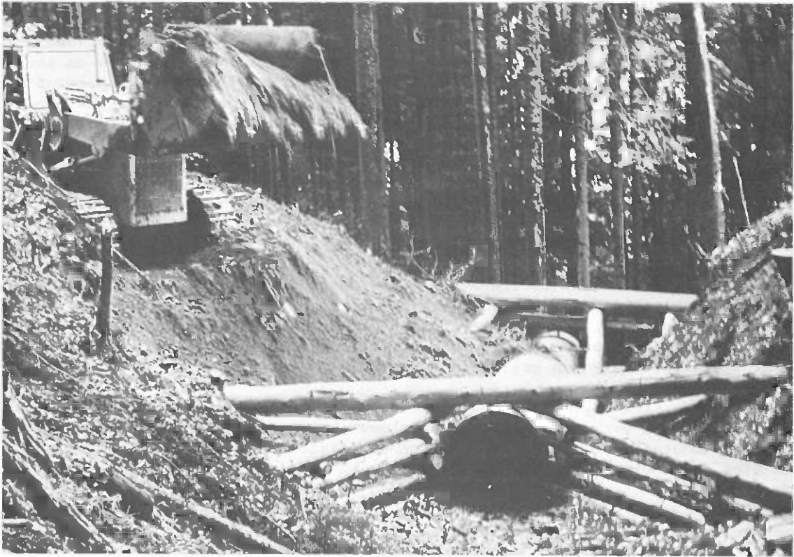
Ravin comblé au moyen d'une pelle mécanique, une buse en béton et un ouvrage en rondins disposés de façon à s'assurer un écoulement naturel des eaux (Photo: FAO)
