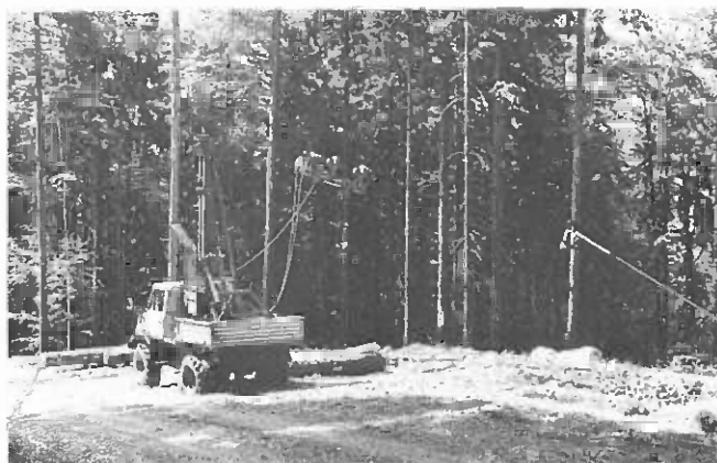
Unité de câblage Urus-Unimog en place sur route, prête à remonter des grumes (Photo: Institut fédéral de recherches forestières)
