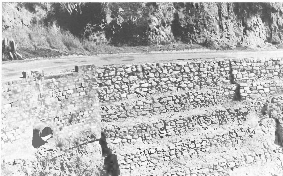
Construction d'un mur de soutènement au moyen de blocs de rochers mis en place sur le talus de déblais par une excavatrice (Photo: O. Sedlak)
