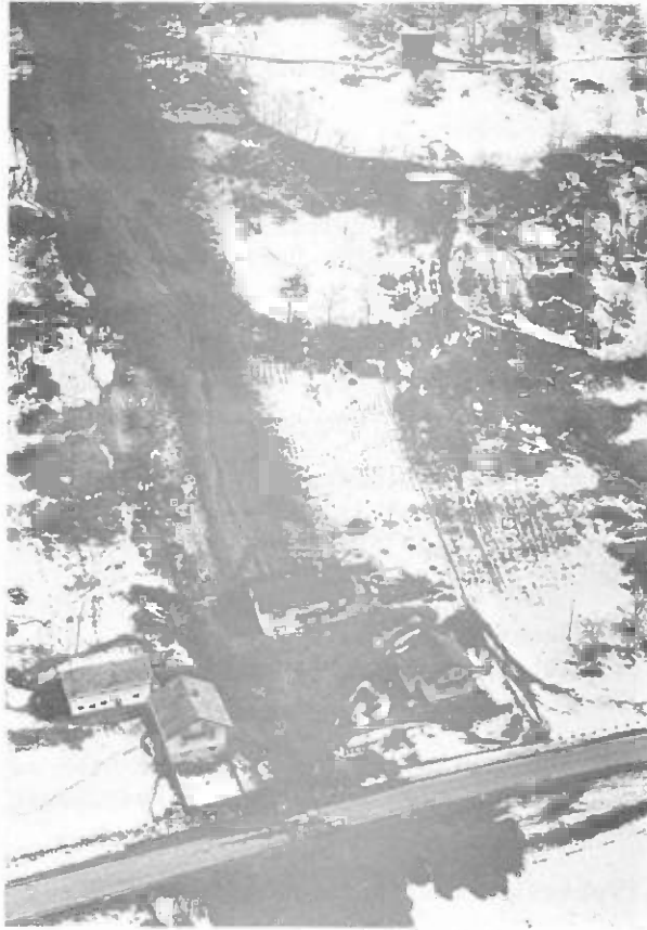
Dévastation de terrains et de bâtiments par un torrent de boue provoqué par une route mal tracée et mal construite (Photo: Wildbach-u. Lawinenverbauung, Kärnten)
