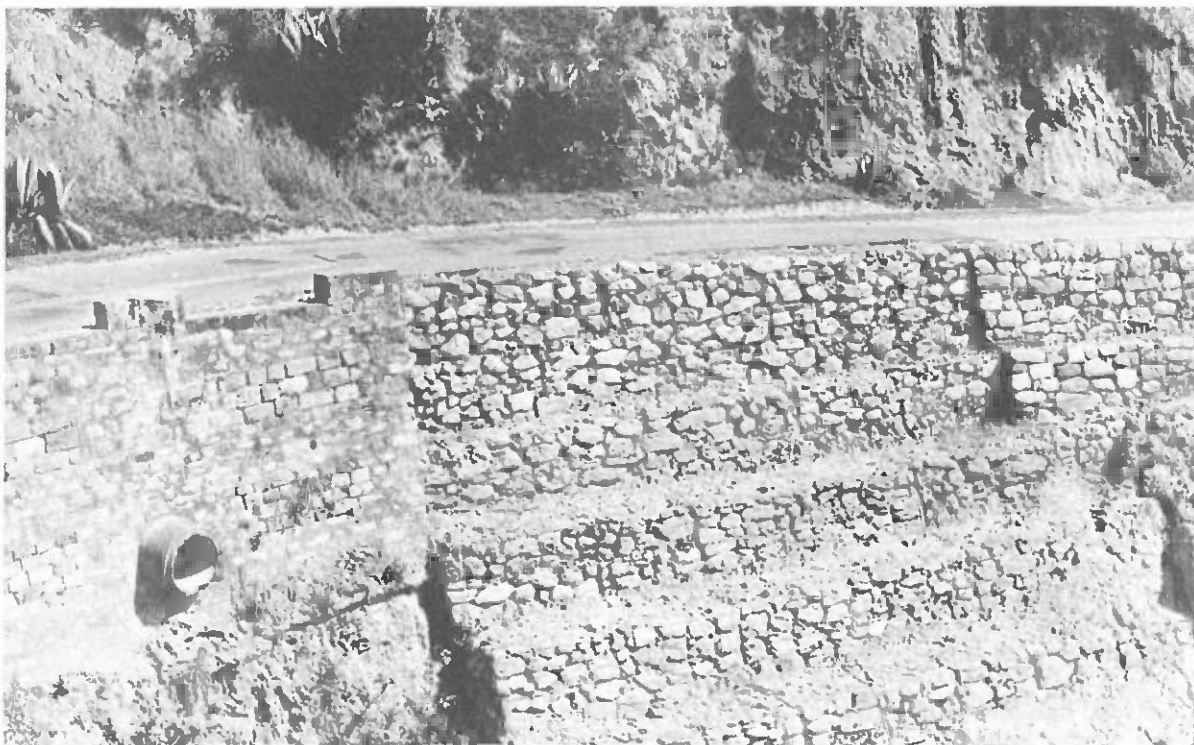
Construcción de un muro de contención formado de bloques de piedra colocados en el talud del desmonte mediante una excavadora (Foto: O. Sedlak)
