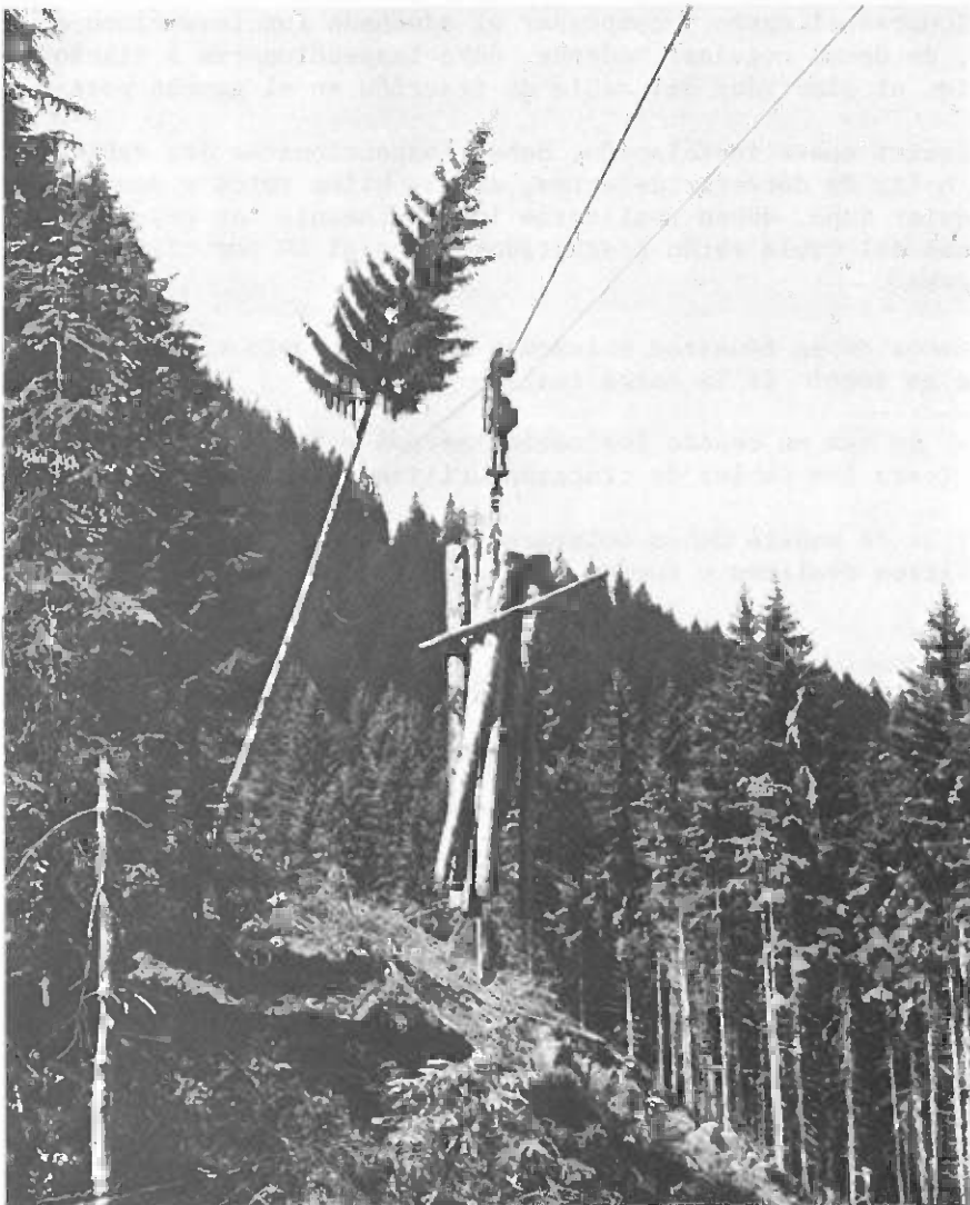
Soporte intermedio en un árbol, utilizado en una operación con cable (Foto: E. Pestal)
