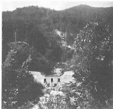
Dique de hormigón para la retención de sedimentos (Foto: M. Jedlitschka)
