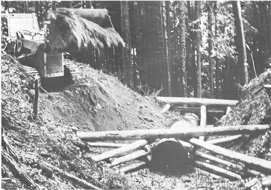
Excavadora-transportadora relleno un barranco, alcantarilla de hormigón y construcción protectora de rollizos emplazadas de modo que queda asegurado el curso natural del agua
