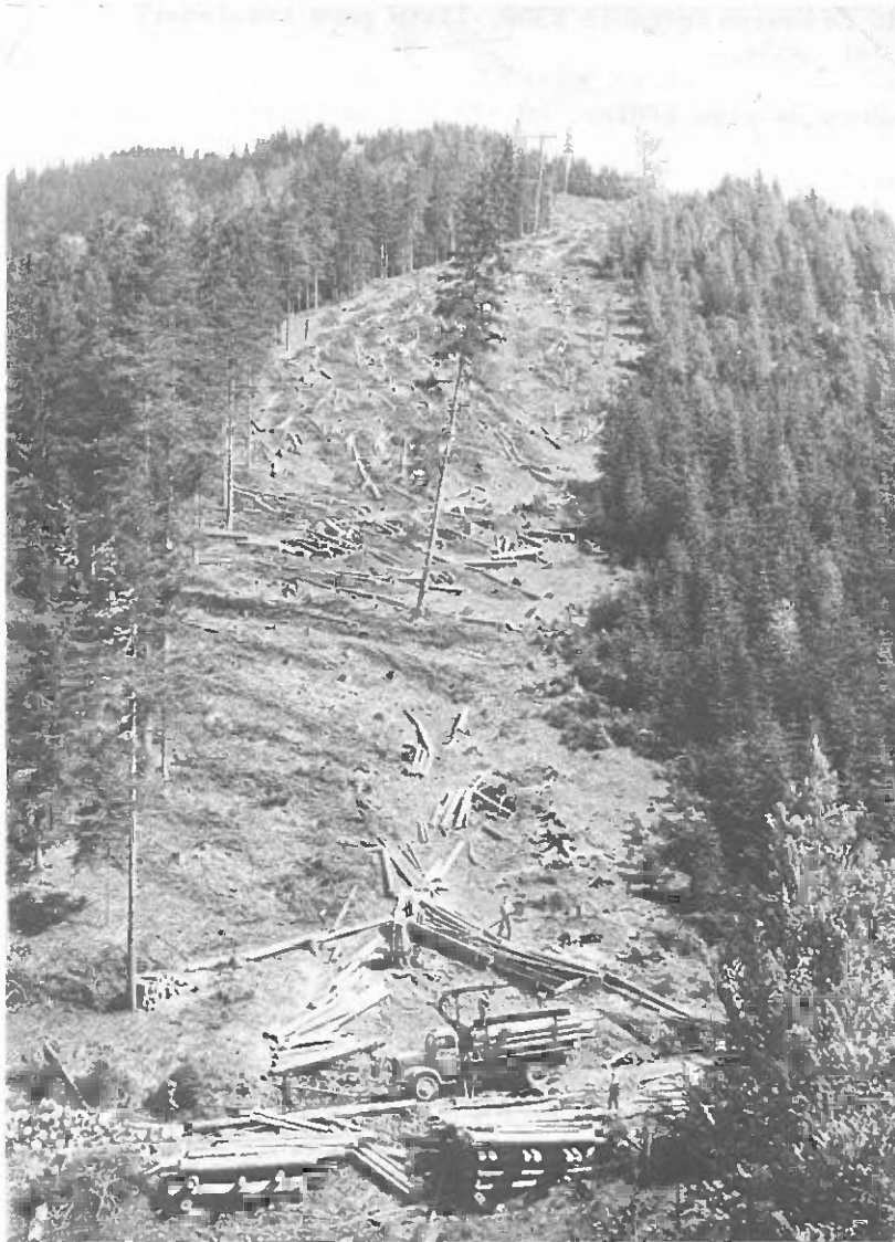
Corta rasa en fajas, con transporte de trozas cuesta abajo mediante cable. El camión se está cargando con un cargador hidráulico (foto: Instituto Federal de Investigación Forestal).
