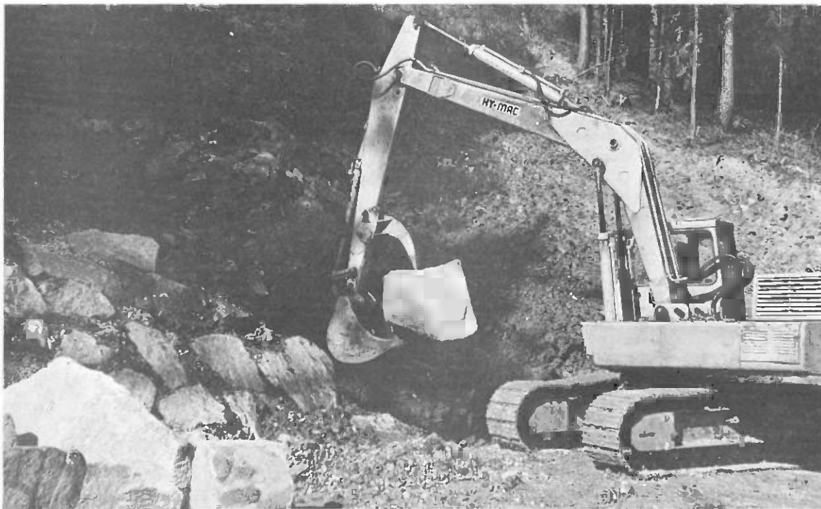
Construcción de un muro de contención formado de bloques de piedra colocados en el talud del desmonte mediante una excavadora (Foto: O. Sedlak)
