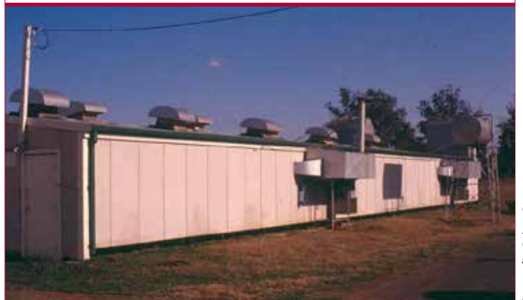
Criadoras de aire caliente a petróleo o a gas en el lado de la nave para la crianza a alojamiento completo: toda el área de cría se calienta a la temperatura requerida
