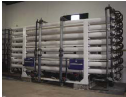
الشكل 1 - محطة تناضح عكسي لمعالجة الماء المسوس في إسبانيا تُنتج 2 500 متر مكعب من المياه العذبة يومياً (باستخدام تكنولوجيا الأغشية)
