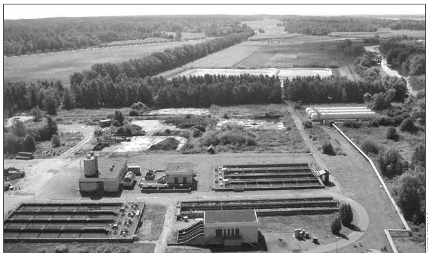
Le système de phytoremédiation de 75 ha formé de saules à Enköping, dans le centre de la Suède: une usine de traitement des eaux usées (au premier plan), des bassins de stockage hivernal des eaux usées (au fond) et des plantations de saules irriguées à l'aide des eaux usées provenant des boues d'épuration
