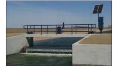
Ouvrage de régulation moderne installé sur un canal du district d'irrigation de l'Est, en Alberta (Canada). Une commande locale alimentée en 24 V continu par des panneaux solaires ajuste automatiquement la position des vannes. Les prélèvements d'eau sur les canaux sont rigoureusement suivis et commandés à partir du PC SCADA. Les pertes sont minimisées et la distribution aux utilisateurs optimisée (Photo: Armtec Ltd)
