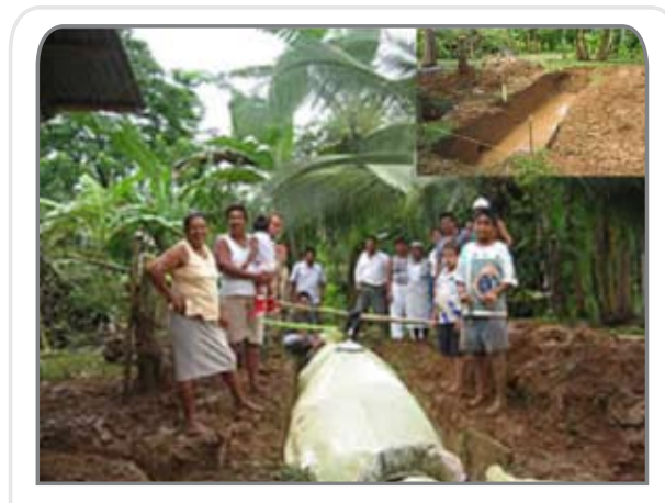
Figura 17. Alternativa de manejo del estiércol bovino: construcción de un biodigestor
