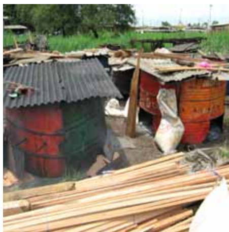
Figure 2: Fumoir circulaire du pont Nomba
