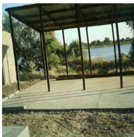
Figure 2. Halle de réception de la matière première (poisson frais) lors du débarquement
