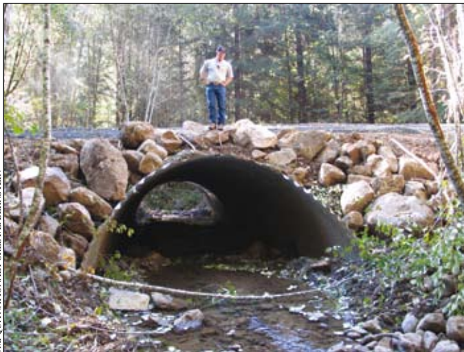
Un ponceau reconstruit dans la Forêt nationale d'Umpqua, Oregon: de nombreux projets du Service forestier financés par l'American Recovery and Reinvestment Act visent à améliorer la qualité de l'eau et à restaurer des habitats et passages importants pour les poissons
