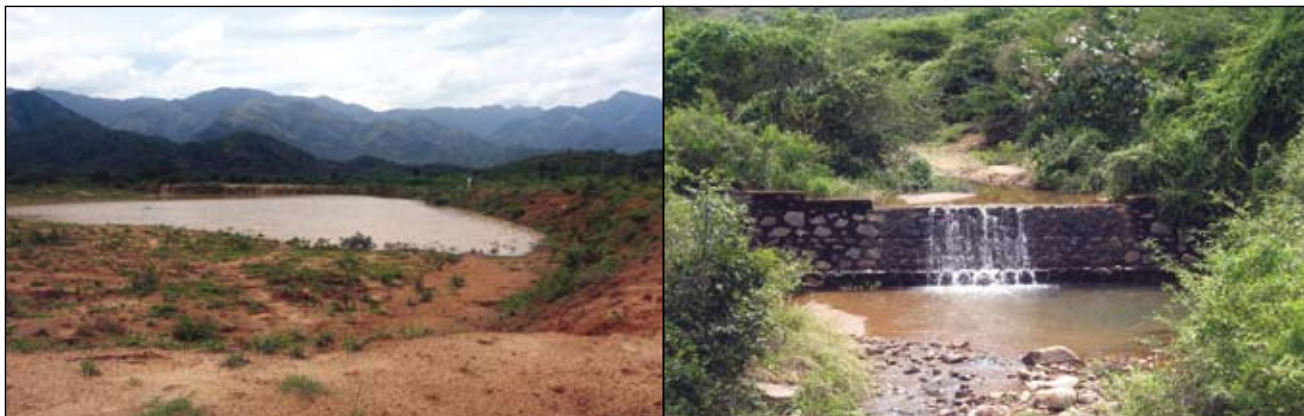
La construction de barrages de retenue et d'autres structures de récolte de l'eau pour combattre l'érosion est à forte intensité de main-d'œuvre
