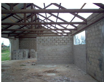
Des murs mitoyens ont été construits pour séparer les différents compartiments du magasin
