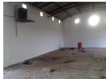
un nouveau plancher en ciment a été étend
