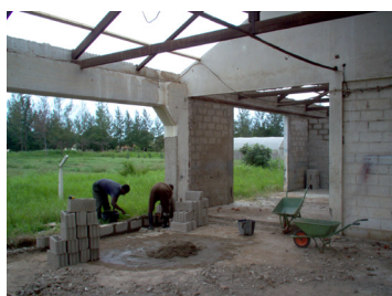
Une nouvelle toiture était posée et des murs extérieurs construits. -
