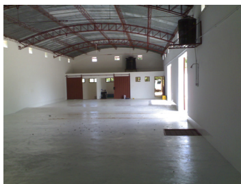
le plancher a été verni à la résine époxyde
