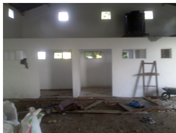
L'intérieur a été complètement rénové
