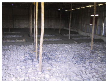
Un plancher renforcé en ciment a été construit
