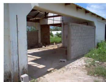
les portes existantes ont été supprimées pour limiter l'accès.
