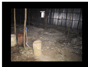
Le sol a été excavé pour enlever la contamination.
