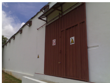
de nouvelles portes ont été ajoutées.
