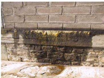
**Éthiopie:** Un déversement prolongé des pesticides a entraîné une infiltration du liquide dans les murs et le plancher du magasin. Cette information doit apparaître dans l'inventaire de manière que la stratégie de sécurisation prévoit et garantisse la décontamination adéquate du site ou la démolition du bâtiment.
