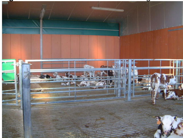
Figure 6 : box collectif – sol caillebotis intégral
