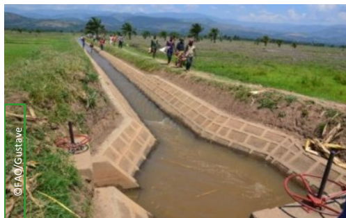
Canal tête morte pour l'irrigation du périmètre de Nyamabere
