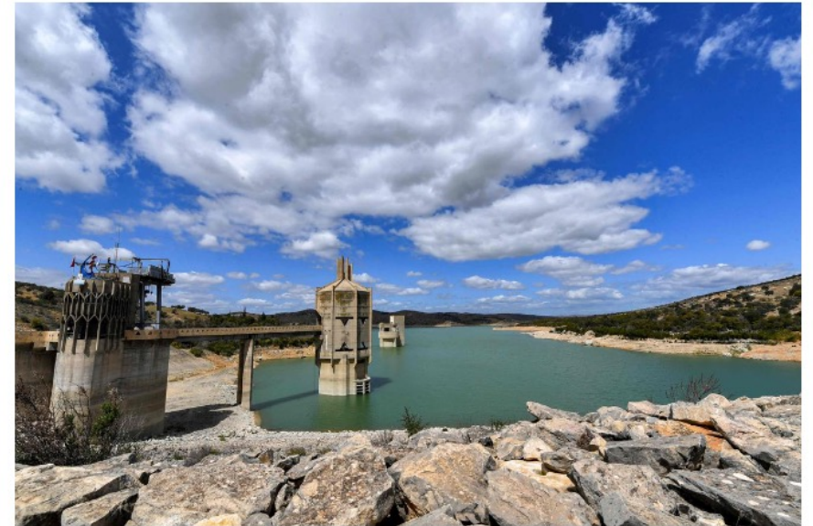
Le réservoir de Sidi Salem, dans la pluvieuse région de Béja, plafonne à seulement 16 % du niveau maximum. FETHI BELAID/AFP
