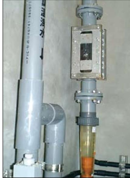
الشكل ٦-٥: محلل كهربائي مع جهاز قياس التدفق مستخدم في تنقية المحار
