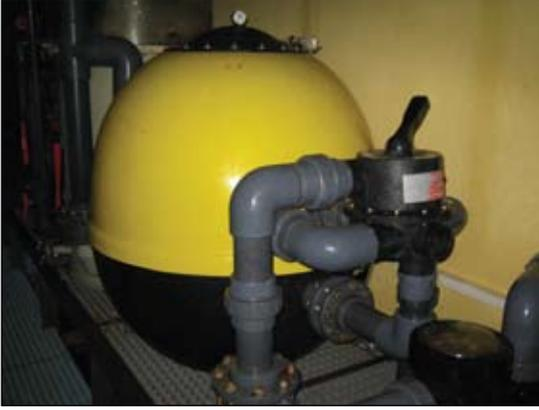
الشكل ٦-٢: مرشح التصفية الرملي المضغوط المستخدم في نظام التنقية
