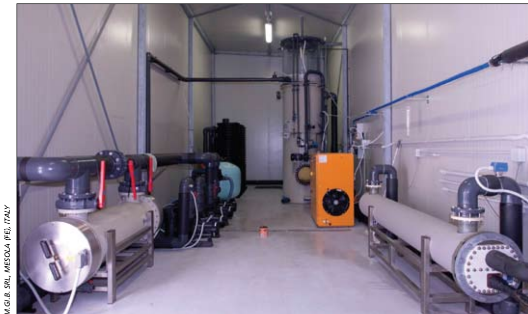
图6.4 安装在一个大型净化车间内的两套紫外线装置
