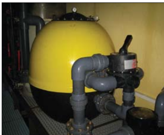
图6.2 净化系统中的压力砂滤池
