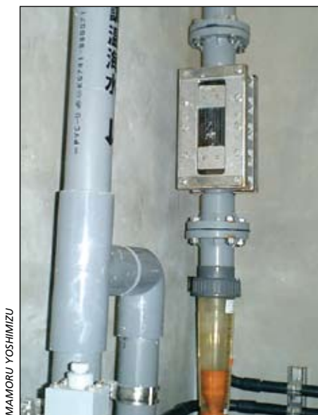
图6.5 牡蛎净化系统中附带流量计的电解槽
