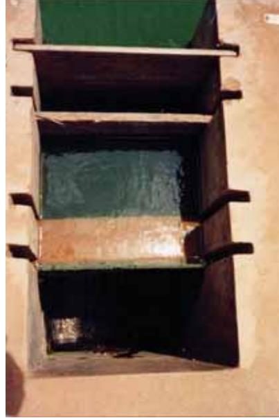
شكل 56 تركيب لمفرخ يعرف أحيانا بإسم صندوق التجميع "مونك" يمكن إستعماله للتحكم في مستوى الماء بالإضافة إلى فحص الماء لمنع فقد روبيان الماء العذب (البرازيل)
