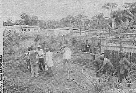
Une vue des participants construisant un hangar.
