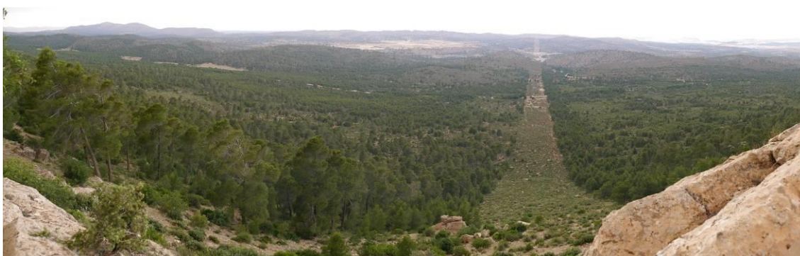
Figure 11 : Exemple d'infrastructures pour la prévention et l'extinction des incendies.
